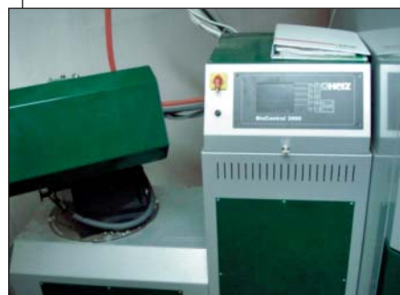
▲ Moduł sterowania w kotłowni Wojciechy z widocznym napędem podajnika zrębków
