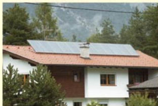
Montaż kolektorów z wykorzystaniem podstawek
